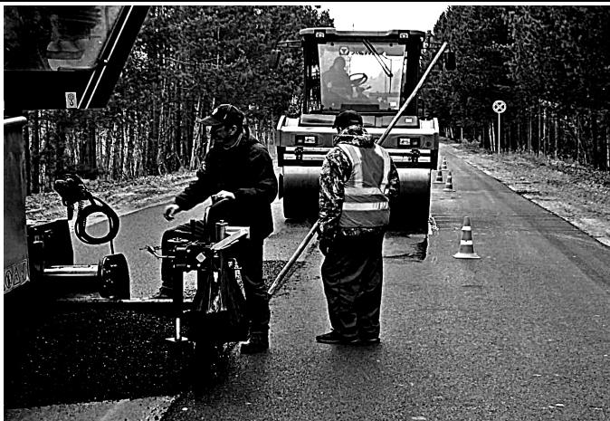
такого укрепления дорогу удалось расширить на полметра с каждой стороны. Асфальт уложен в два слоя. На этой неделе «Прогресс» завершает нанесение дорожной разметки и подсыпку обочин.
