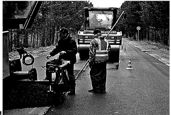
такого укрепления дорогу удалось расширить на полметра с каждой стороны. Асфальт уложен в два слоя. На этой неделе «Прогресс» завершает нанесение дорожной разметки и подсыпку обочин.
