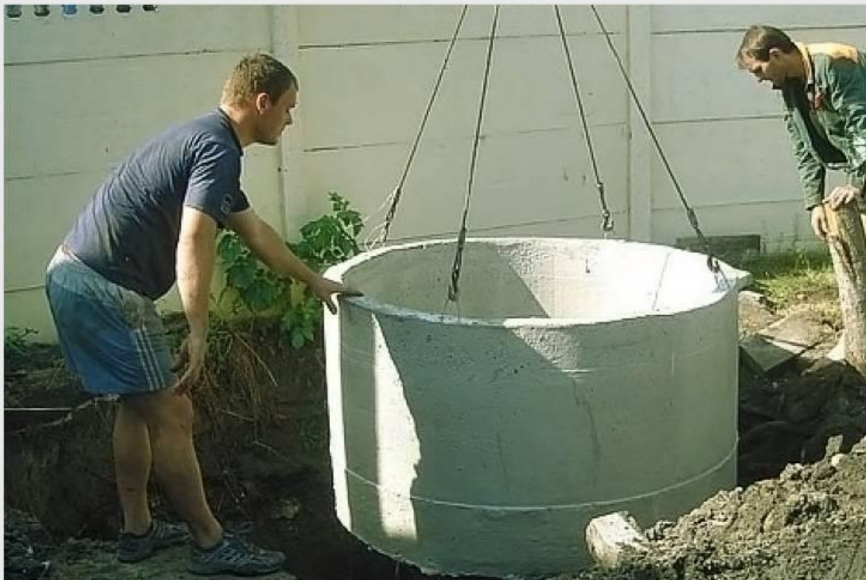
Бетонные кольца для септика
