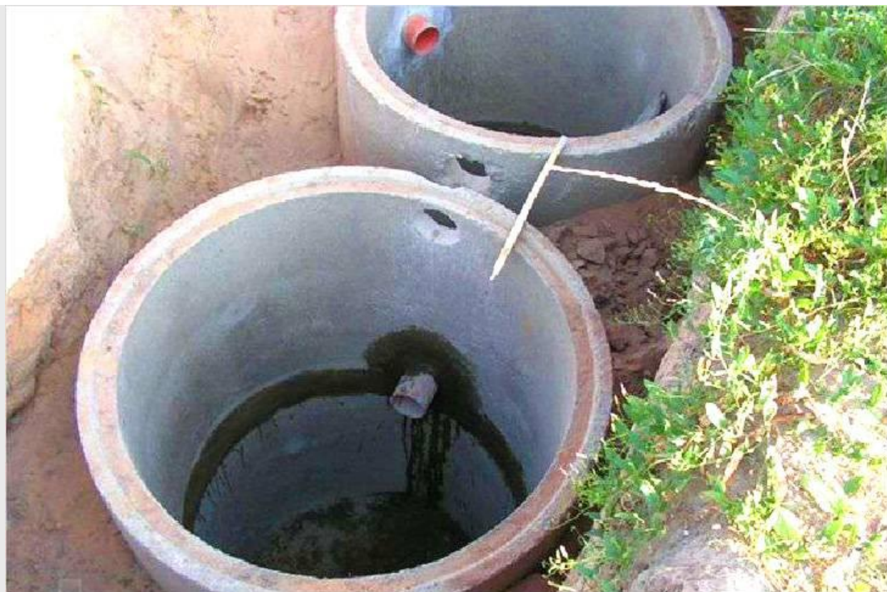
Установка бетонных колец
