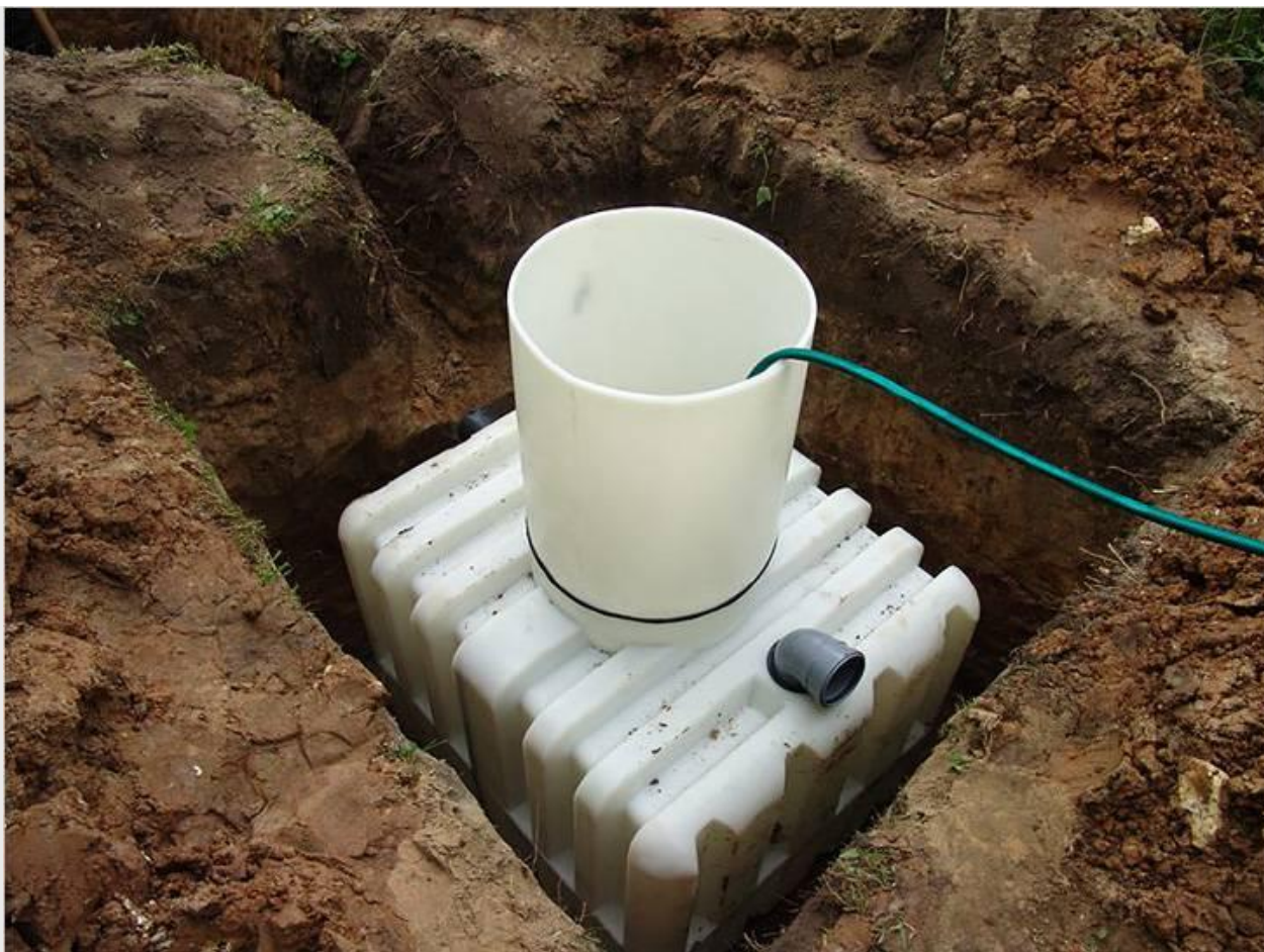
Монтаж пластикового септика
