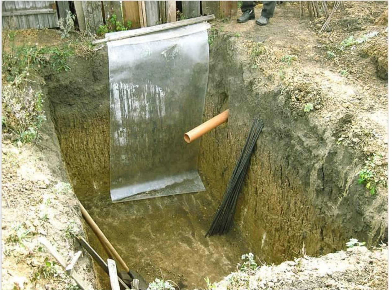
Подвод канализационной трубы
