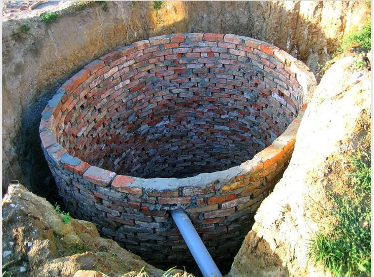
Строительство из кирпича
